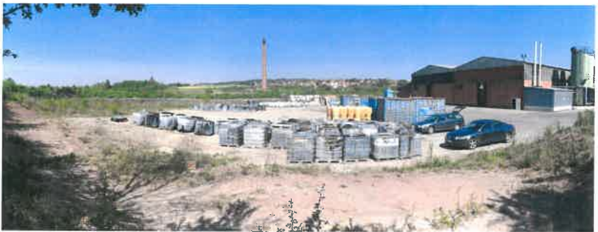
Panoramafoto des zukünftigen Hallenstandorts aus südöstlicher Richtung
