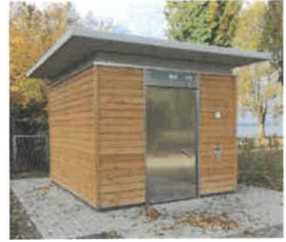
Holzfassade; umlaufendes Flachdach
