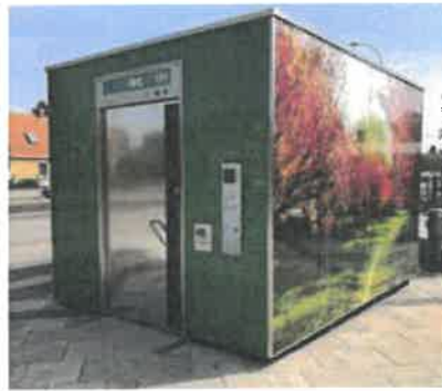
Glasfassade bedruckt; Flachdach
