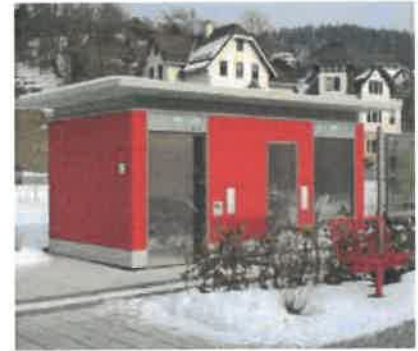
HPL-Fassade; umlaufendes Flachdach
