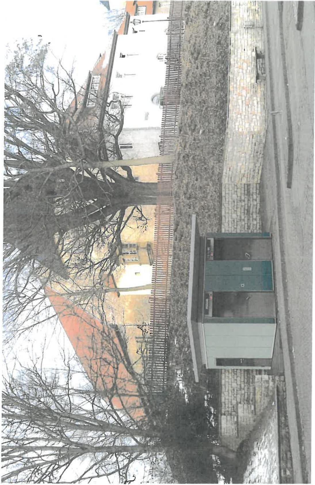
**WC-Anlage Typ R200B-Glasfassade, umlaufendes Beton-Vordach, Schöningen**
