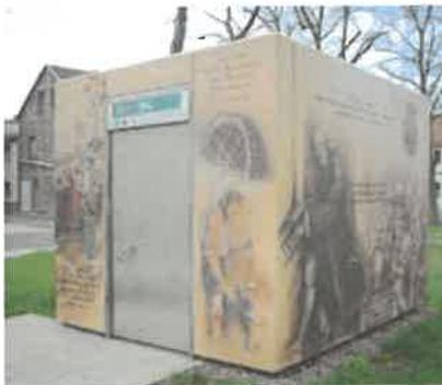
Betonfassade bedruckt; Flachdach
